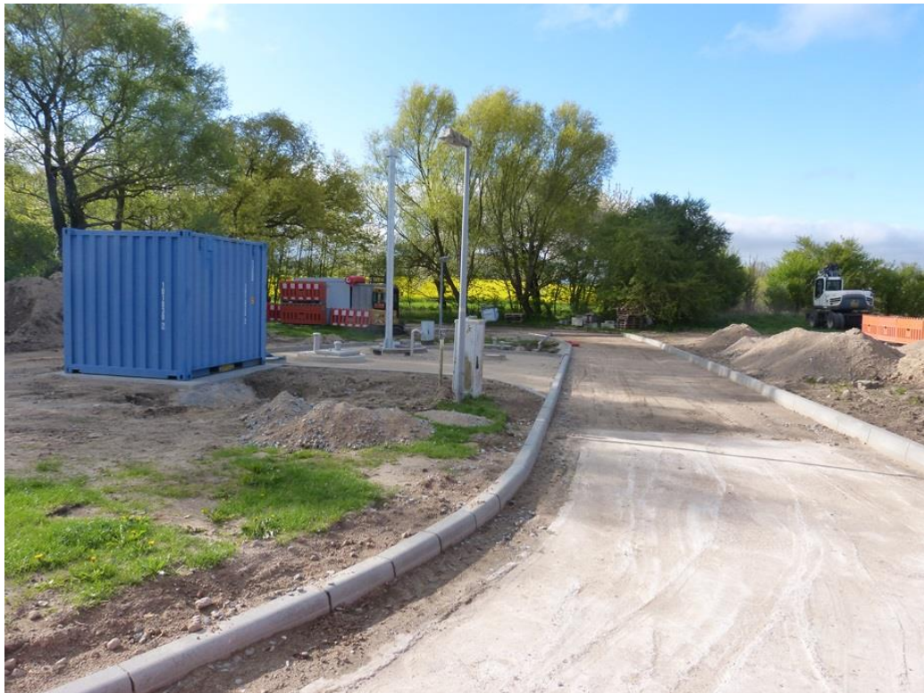
Bild 8: Östlich an das Sondergebiet (SO NV) angrenzende Baustelle
