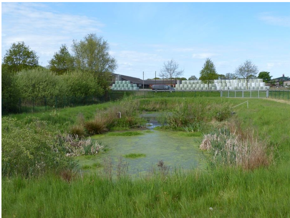
Bild 10: Regenwasserüberlaufbecken südlich des Plangebiets
